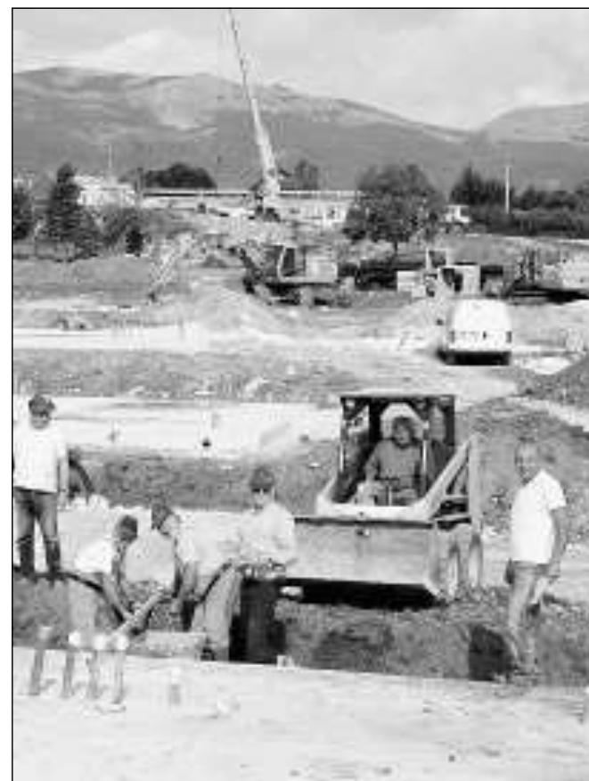
Volontari alpini al lavoro per la realizzazione delle casette prefabbricate nel nuovo villaggio di Fossa
