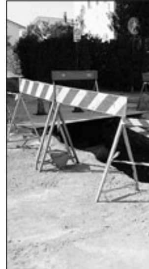
Il cantiere aperto
