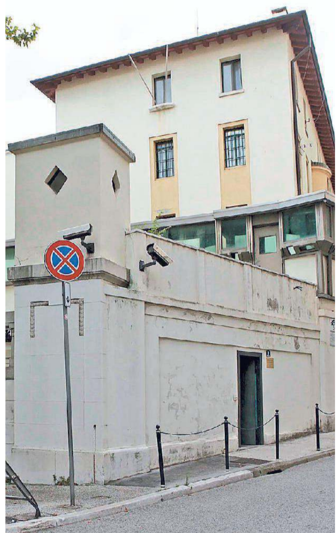
Una parte della struttura detentiva
