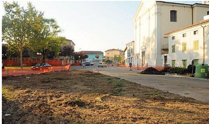
I lavori alla rotonda del Mercaduzzo
