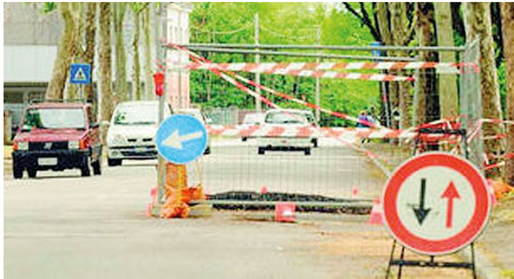
Lavori stradali in via Lungo Isonzo (Foto Bumbaca)
