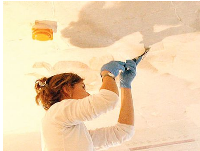
Verifica sui controsoffitti
