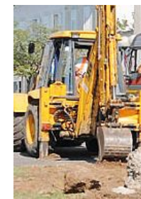
Lavori al Mercaduzzo
