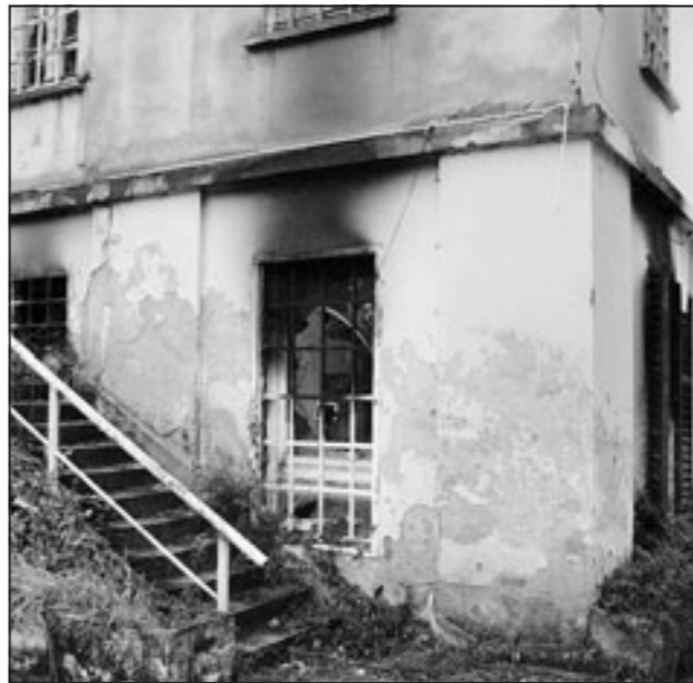
L'esterno dell'edificio in cui si è sviluppato l'incendio
